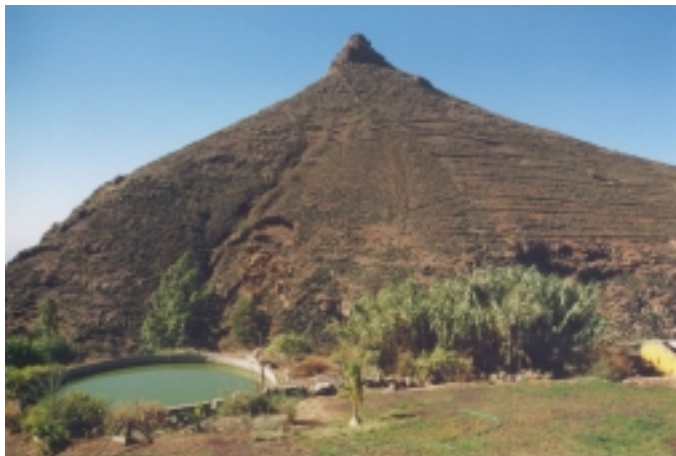
Pflanzenkläranlage mit Brauchwasserspeicher, Pension El Refugio
