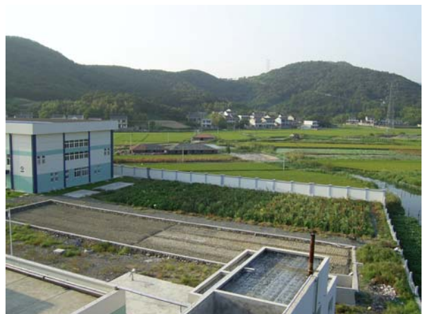
Pflanzenkläranlage im Juni 2005
