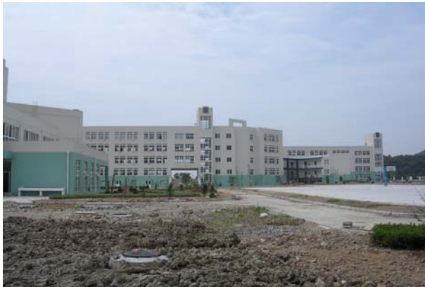
Außenanlagen im Rohbau Juni 2004
